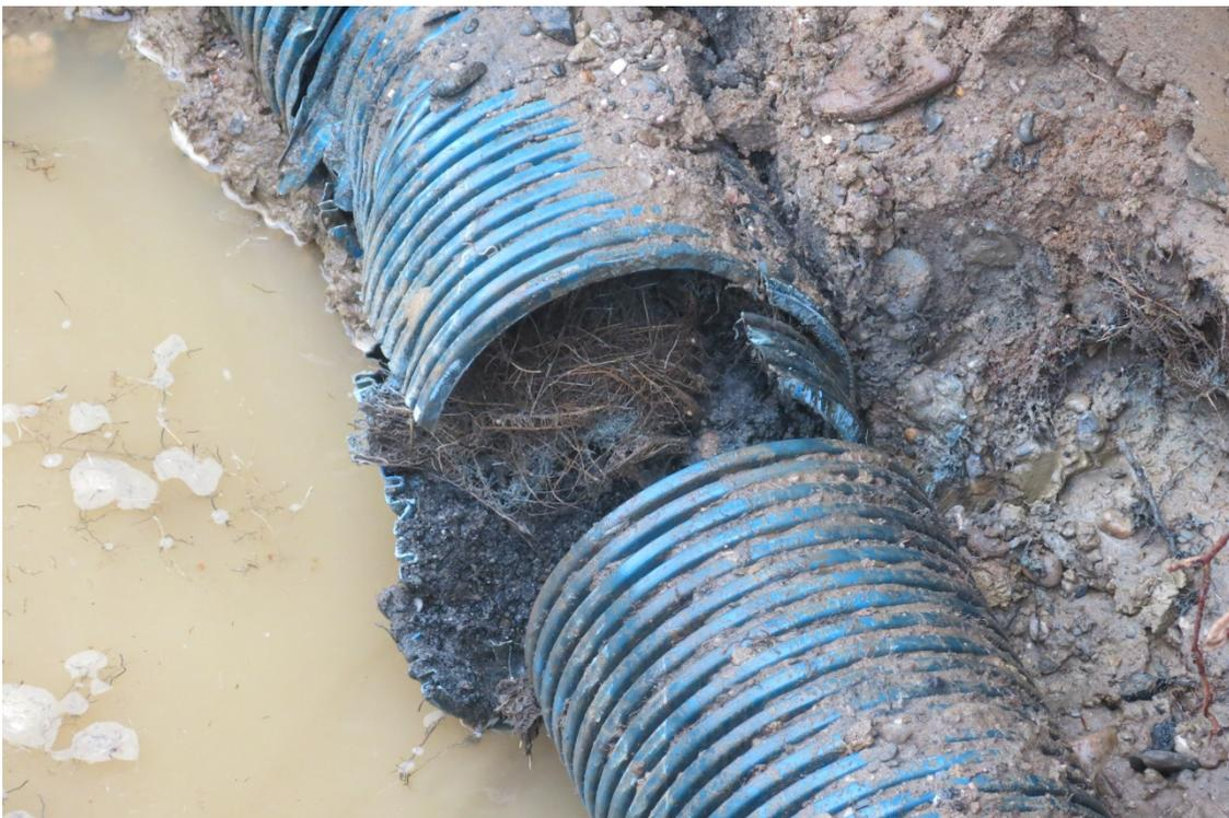
Im Zuge der Baumaßnahme wurde auf einer Länge von etwa 30 m eine durch Wurzelwerk verstopfte Sickerrohrleitung ausgebaut und durch ein „geschlossenes“ Kanalrohr ersetzt. Im Anschluss an die Behandlung der Reflexionsrisse und der Erneuerung der Rohrleitung wurde über die gesamte Fahrbahn eine 4 cm starke Asphaltdeckschicht aufgebracht.
