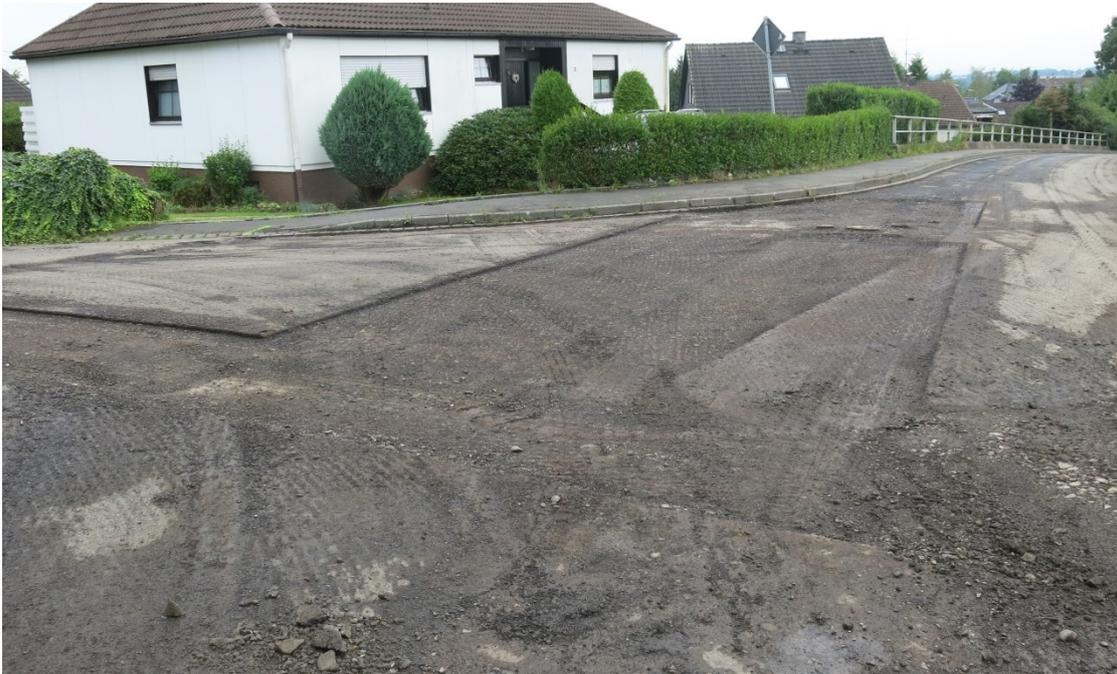
Nach Abtrocknung der Fahrbahn wurden die erkennbaren Reflexionsrisse von der Bauleitung markiert, die dann in einer Breite von 1,0 m und 4 bis 6 cm tief ausgefräst wurden. Diese Stellen wurden dann mit einem Gittergewebe ausgelegt und mit einer Binderschicht aufgefüllt.
