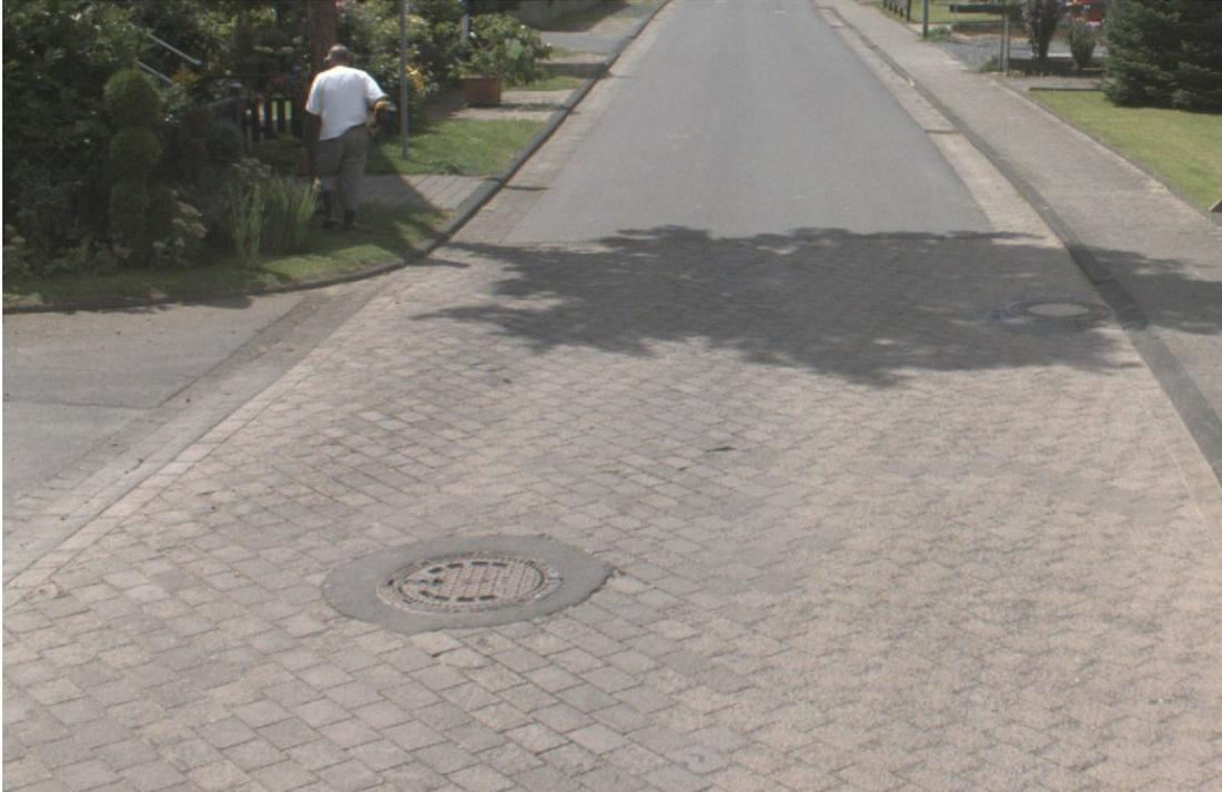
Es sind deutliche Fahrspuren und Pflasterschäden sichtbar.
