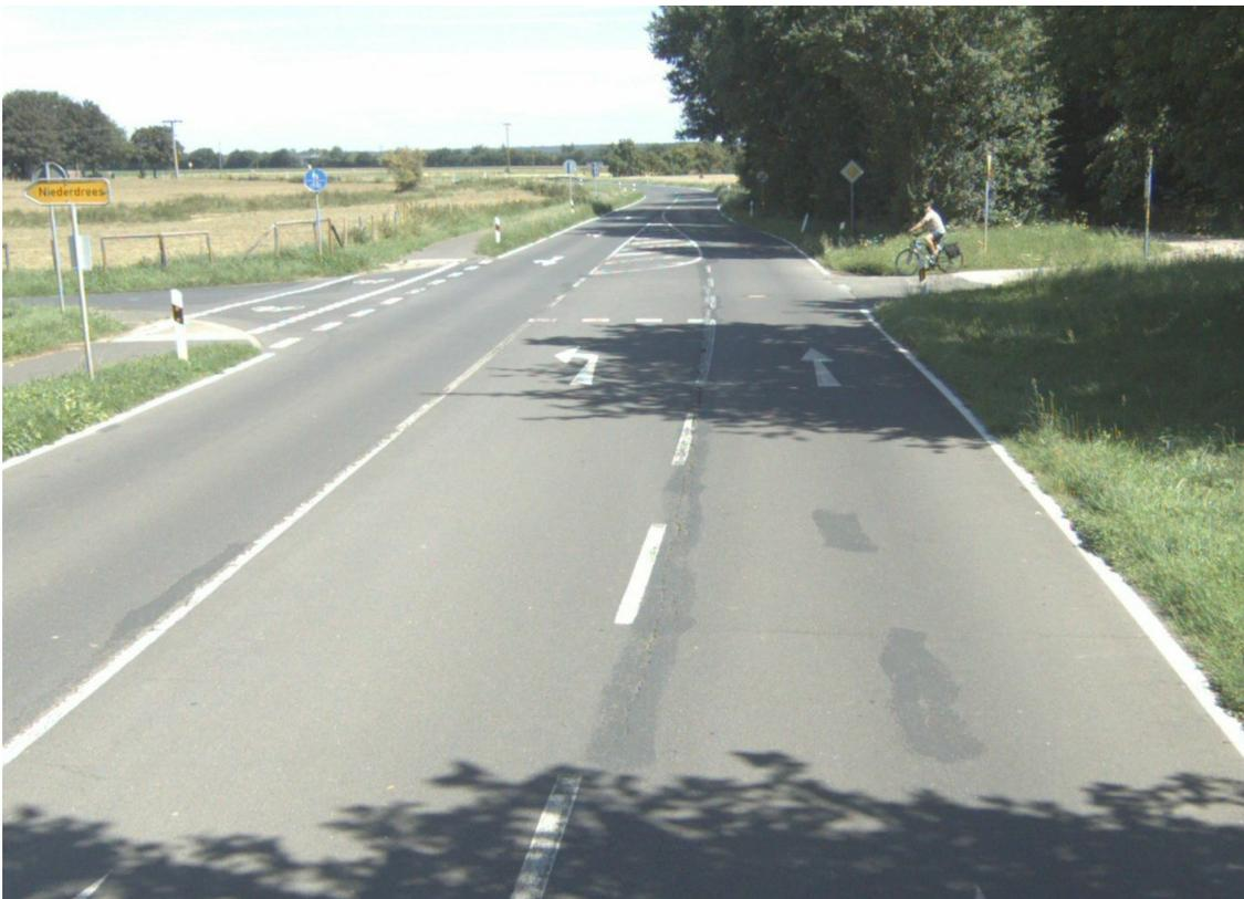
Nach Abtrocknung der Fahrbahn wurden die erkennbaren Reflexionsrisse von der Bauleitung markiert, die dann in einer Breite von 1,0 m und 4 cm bis 6 cm tief ausgefräst wurden. Diese Stellen wurden dann mit einem Gittergewebe ausgelegt und mit einer Binderschicht aufgefüllt.
