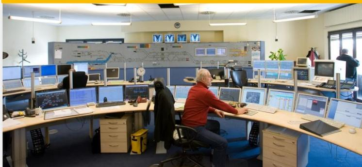
aktiviert wird, schaltet sich automatisch eine der Kameras an der jeweiligen Bahn-Haltestelle auf einen Monitor in der Leitstelle. Über die Info-Tasten an Notrufsäulen können die Mitarbeiter des Info-Platzes erreicht werden und Auskünfte erteilen.
