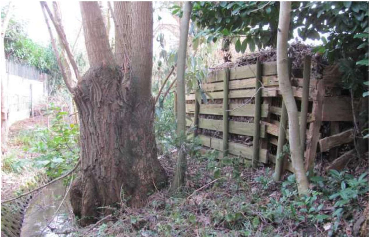
Massnahmen: Rückbau der Uferbefestigung und der Ablagerungen; Herstellung eines naturnahen Gewässerprofils
