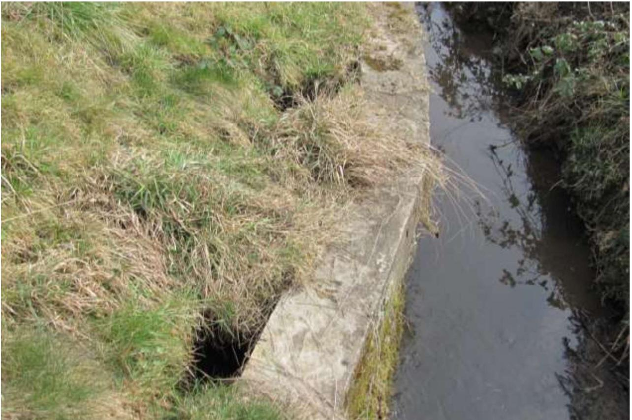
Massnahmen: Rückbau der Ufermauern und Brücken; Herstellung eines naturnahen Gewässerprofils
